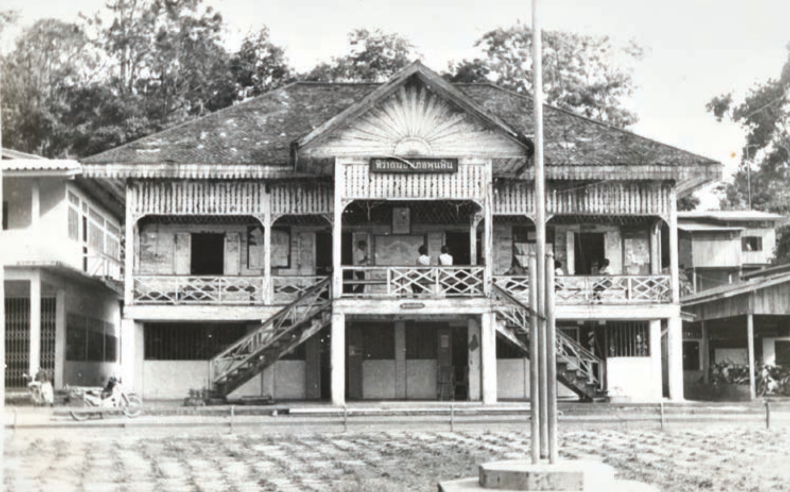
ที่ว่าการอำเภอพนมพิณ (หลังที่ ๑) ตั้งอยู่ที่ถนนจุลจอมเกล้า ตำบลท่าข้าม อำเภอพนมพิณ จังหวัดสุราษฎร์ธานี ภาพยุค ๒๕๐๐ (ภาพจากนายทศพล งานไพโรจน์)
